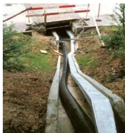
Długi odcinek rurociągu przesyłowego ciekłego wodoru
