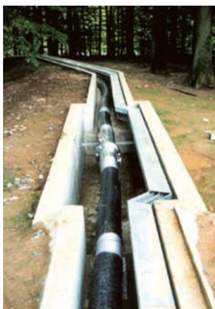
Długi odcinek rurociągu przesyłowego ciekłego wodoru
