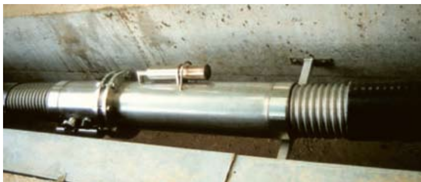
Złącze rury CRYOFLEX® w komorze
