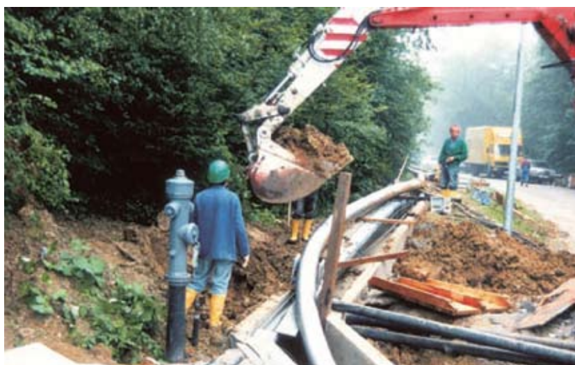
Układanie długiego odcinka rurociągu (płynny tlen)
