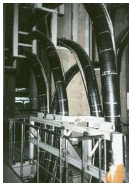
Kabel nadprzewodnika chłodzony wykorzystywany przy badaniach syntezy jądrowej w Japonii (NIFS)
